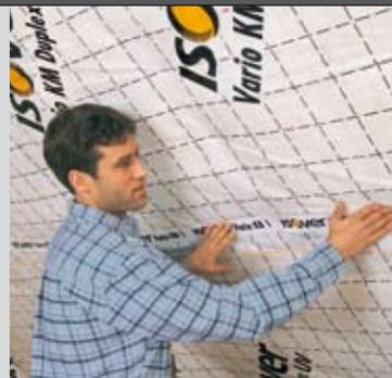
Folienstöße ca. 10 cm überlappen und mit Vario KB 1 oder Vario MultiTape verkleben. Es ist zu beachten, dass nur auf der glatten Seite der Folie eine dauerhafte Verklebung möglich ist.
