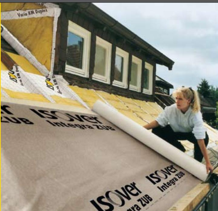
Diffusionsoffene Unterdeckbahn Integra ZUB parallel zur Traufe verlegen und straff gespannt antackern.
