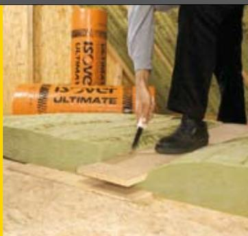
ULTIMATE Klemmfilz ausrollen. Lichten Sparrenabstand plus 1 cm Klemmzugabe abmessen. Abschneiden.
