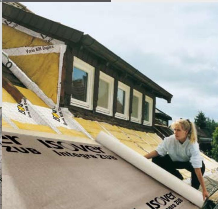
Sanierungsfilz Integra ZSF auf Sparrenfeldbreite plus 1 cm zuschneiden und einlegen.
