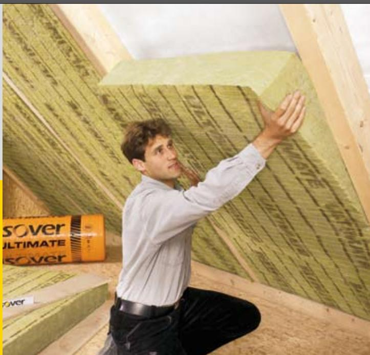
ULTIMATE Klemmfilz lässt sich extrem flexibel und sicher verarbeiten. Die hohe Klemmwirkung bis 1.200 mm Sparrenabstand ermöglicht neue Konstruktionen.
