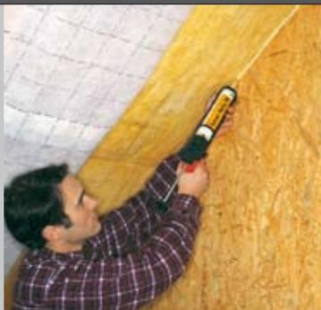
Klimamembran Vario KM/Vario KM Duplex UV leicht andrücken. Dabei auf leichten Durchhang achten. Bei Unsicherheiten bezüglich der Tragfähigkeit des Untergrundes: Probeverklebung durchführen und ggf. Anpresslatte verwenden.
