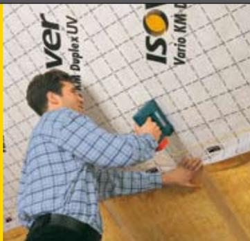
Die Vario KM Duplex UV in Abständen von ca. 20 cm am Sparren antackern. Im Gegensatz zu Vario KM kann die KM Duplex UV straff gespannt angetackert werden. Die Klimamembran ist für eine sichere Verklebung richtig verlegt, wenn die Beschriftung lesbar ist.
