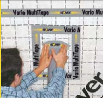
Durchdringungen oder Plattenstöße werden mit dem flexiblen Vario MultiTape einfach und effizient luftdicht verklebt. Auch Überlappungen der Vario KM Duplex UV können luftdicht mit dem spurhaltigen Vario MultiTape abgeklebt werden.
