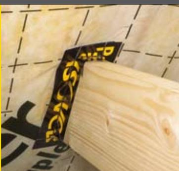
Für Sparren und Zangen: je nach Sparren einen Streifen flexibel abziehen und passgenau ankleben. Für jede Ecke passgenau flexibel faltbar – ob Fenster oder äußere Ecken. Immer von Hand abreißbar!
