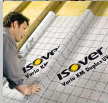
Bei der Dachsanierung von außen ist die Vario KM Duplex UV einfach über die Sparren zu legen. Dabei ist zu beachten, dass die Vliesseite zum Sparren verlegt wird und die Schrift zu lesen ist.
