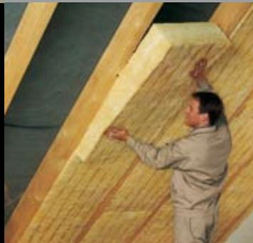
Zugeschnittene Dämmplatte Integra ZKF 1 zwischen die Sparren klemmen, auf fugendichten Anschluss der Platten untereinander achten.
