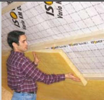
Zugeschnittene Dämmstoffplatte Integra UKF zwischen die Lattung einklemmen.
