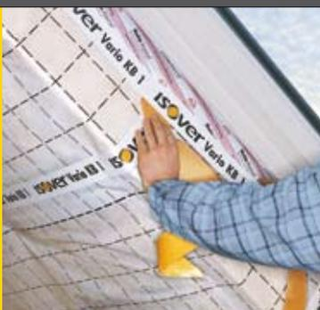
Besonders bei Fenstern auf Luftdichtheit achten. Risse und Fehlstellen mit Vario KB 1 oder MultiTape zukleben.
