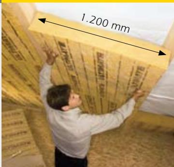
Zugeschnittene Dämmplatte zwischen die Sparren klemmen. Auf fugendichten Anschluss der Platten untereinander achten.
