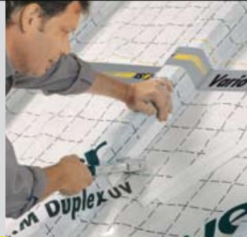
Überlappungen der Dampfbremse bei der Dachsanierung von außen können fachgerecht und luftdicht abgeklebt werden, ebenso senkrechte Plattenfugen und -stöße im Außenbereich, z.B. OSB-Platten.
