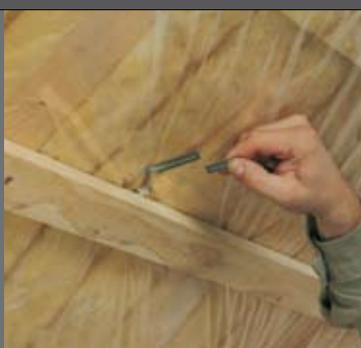
Für UKF 2 gilt: Zuschnitt zunächst wie UKF 1 (siehe oben). Vor dem Einklemmen des Dämmstoffs wird der Untersparren-Montagebügel Integra UMB hinter der Standardlattung eingehängt. Anschließend Platte UKF 2 in die Montagebügel einlegen.
