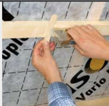
Universal-Montagestreifen Isovor UniFix mittig antackern. Materialbedarf: 4 Befestigungen pro  $\text{m}^2$ . Dann Dämmstoff einlegen.
