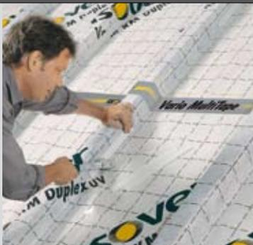
Diffusionsoffene Unterdeckbahn Integra ZUB parallel zur Traufe verlegen und straff gespannt antackern. Zu den weiteren Komponenten des Integra ZSF Dachmodernisierungs-Dämmsystems und zur Verlegung wenden Sie sich bitte an ISOVER Dialog unter 0800/501 5 501.
