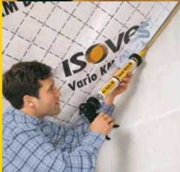
Mit Dichtstoff Isover Vario DS oder Vario ProTape (Dichtstoff von der Rolle) an Bauteile anschließen. Bei Vario DS gegebenenfalls eine Anpresslatte verwenden.
