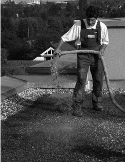
Bei der Bauder Anspritzbegrünung wird mit Spezialmaschinen ein breiiges Gemisch aus verschiedenen Zuschlagstoffen, Sedumsprossen und ggf. Saatgut hergestellt und in einem Arbeitsgang maschinell auf das Vegetationssubstrat aufgespritzt. Damit ist die Bauder Anspritzbegrünung die rationellste Methode, große Dachflächen extensiv zu begrünen.
