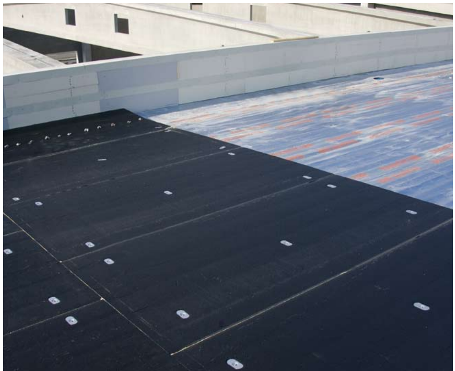
Abb. 1: Speziell für den Einsatz auf dem Industrielichtdach ist BauderPIR FA konzipiert. Aufgrund der guten Wärmedämmeigenschaft können die Dämmstoffdicken reduziert werden. In Kombination mit der geringen Rohdichte ermöglicht das großformatige und leichte Dämmplatten.
