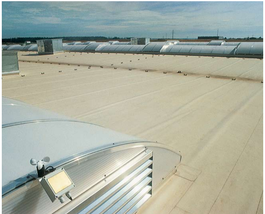
Abb. 2: Flachdachaufbau mit Kunststoff-Abdichtung
