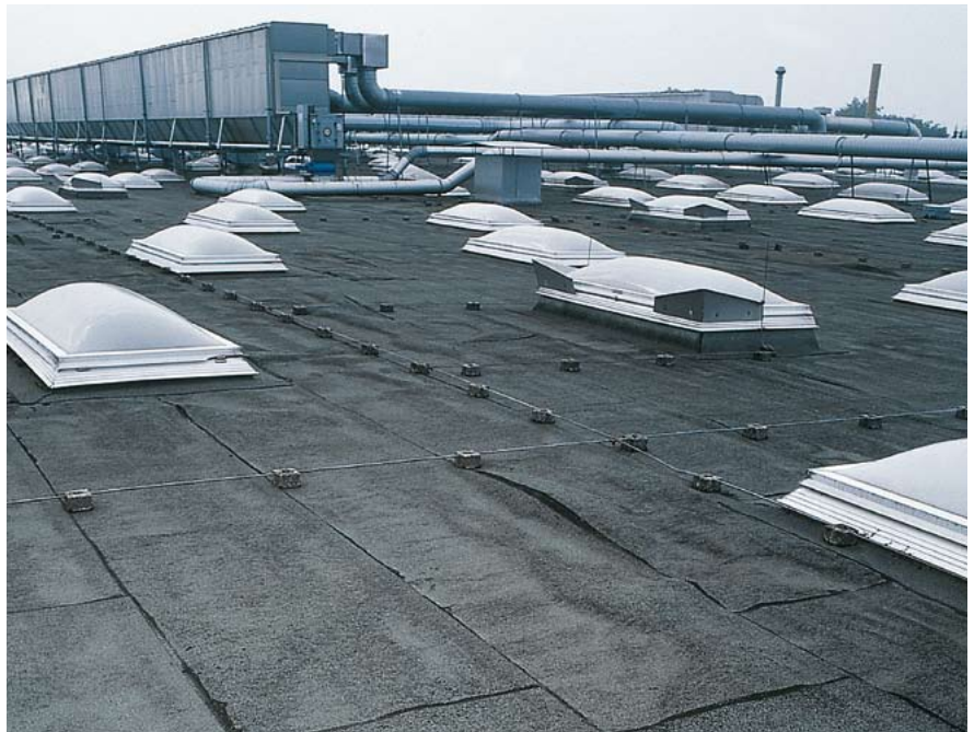
Abb. 2: Das Dach vor der Sanierung
