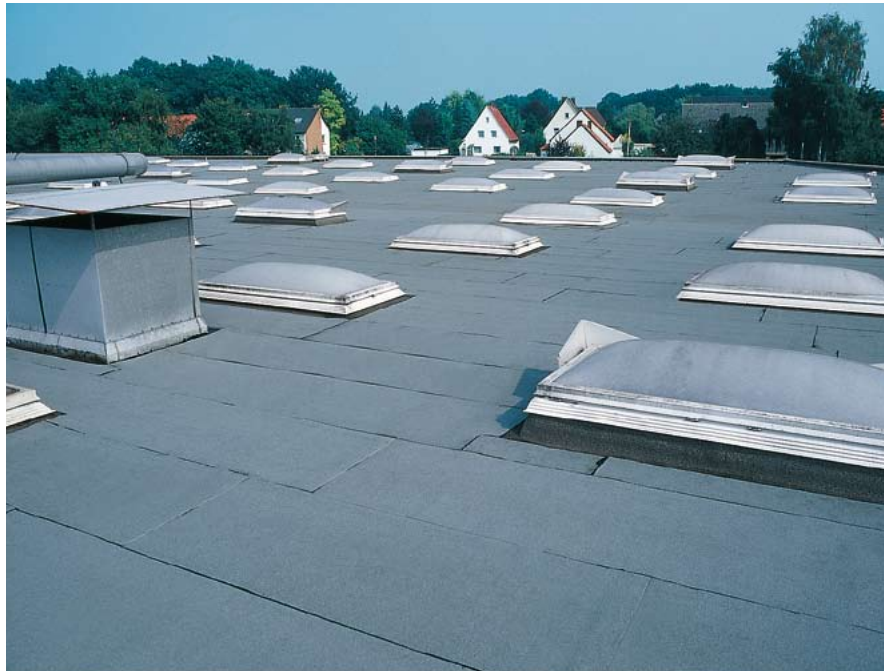
Abb. 1: Das Dach nach der Sanierung
