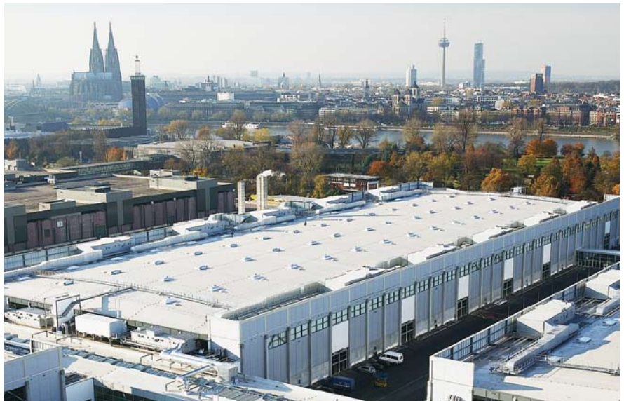
Abb. 1: Industrie-Leichtdach mit einlagiger Kunststoff-Abdichtung
