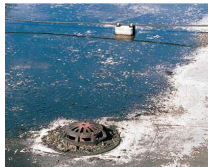
Abb. 4: Pfützen und Schmutzablagerung
