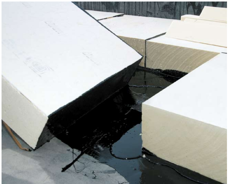
Abb. 2: Bauder PIR Kompaktdach ist ein Flachdachsystem, bei dem die Abdichtungsschichten und der Wärmedämmstoff untereinander und mit dem Untergrund kompakt verklebt sind. Damit ist ein Unterlaufen der Abdichtung bei evtl. Beschädigung ausgeschlossen.
